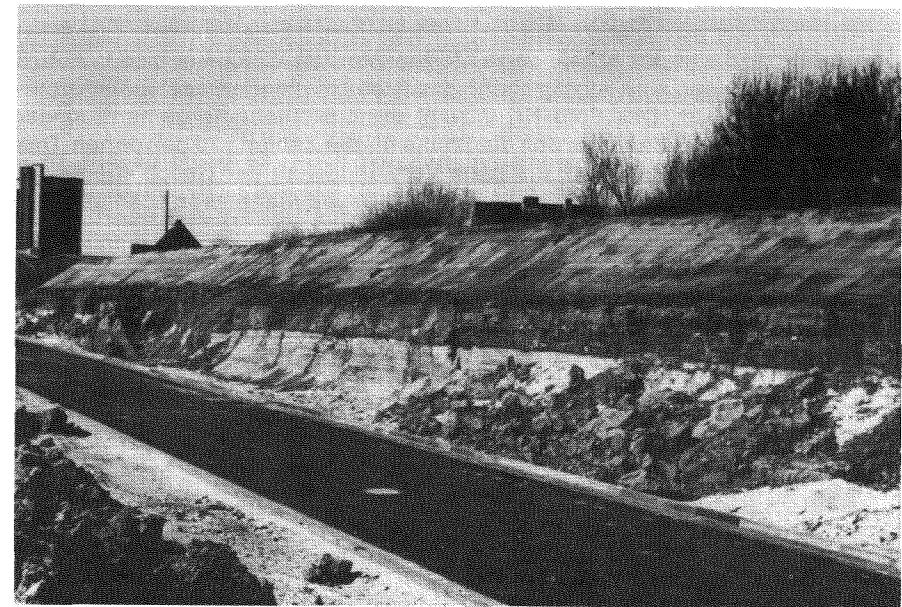
Foto 1: Straßenaufschluß östlich der Zuckerfabrik in St. Michaelisdonn, Nordseite. Geschiebemergel des Burg-Vorstoßes mit Steinanreicherungslagen über Feinsanden. Die hangenden Schmelzwassersande sind größtenteils abgebaut worden. Aufnahme: G. Schlüter 1973
